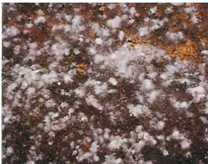
Foto 4 - Sviluppo di muffe su deposito di guano.
